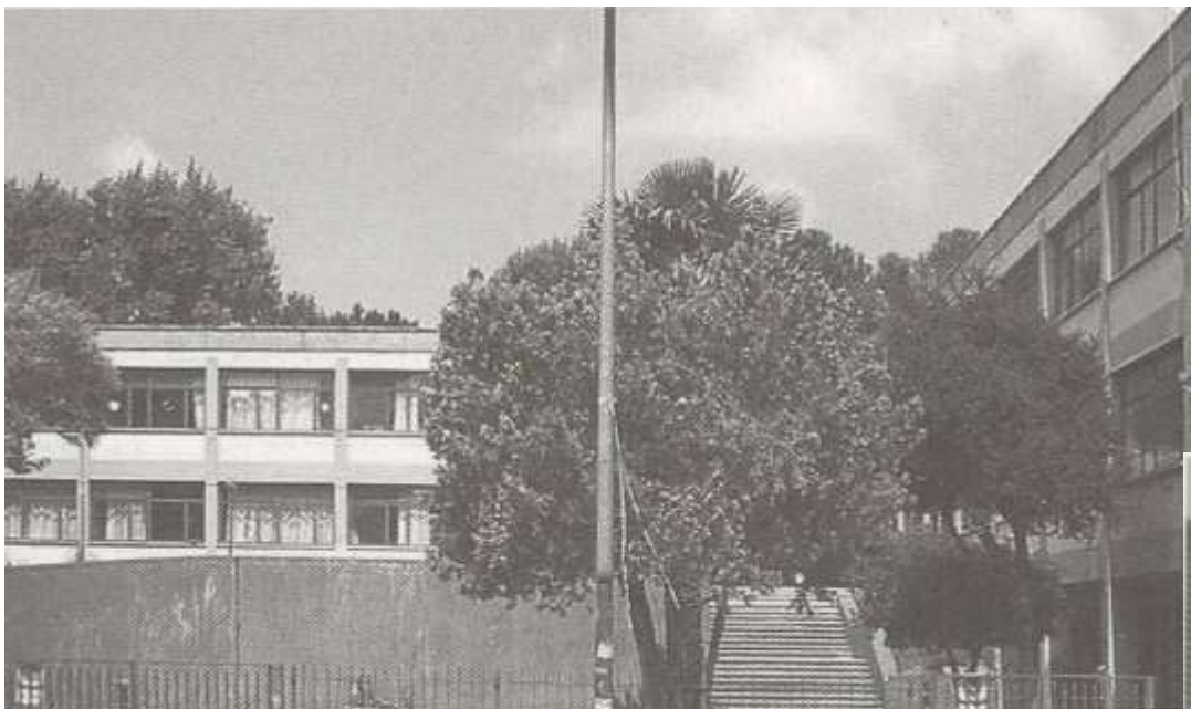
Vista scuola ante intervento
